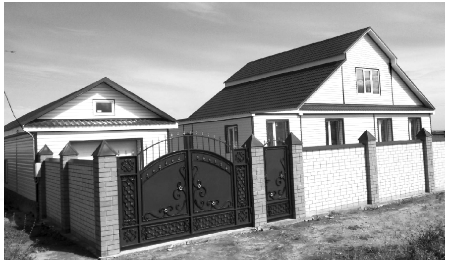
Этот жилой дом в Николаевском районе был построен с нуля.
